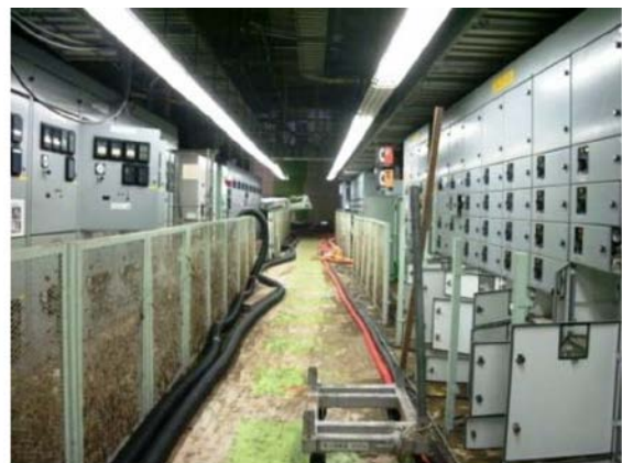
被水した1号機タービン建屋1階電源盤
